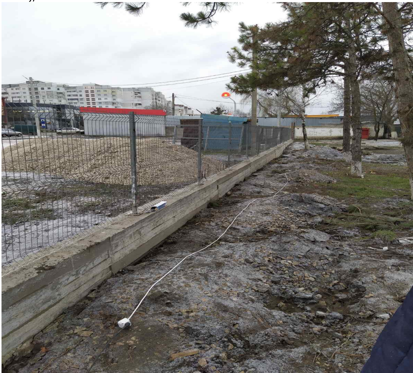
Imaginea nr. 13. Construcția gardului de la SPR 2 Canal.
