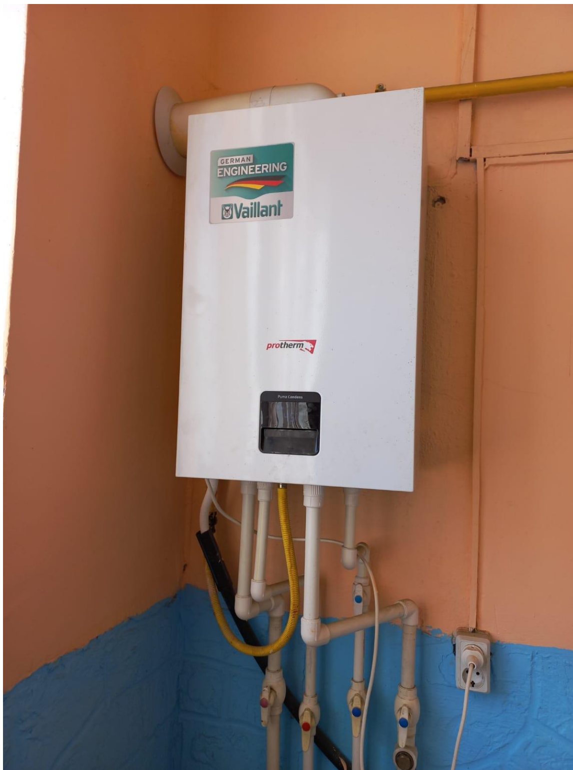
Imaginea nr. 4. Procurarea cazanului la SPR nr. 2 canal
