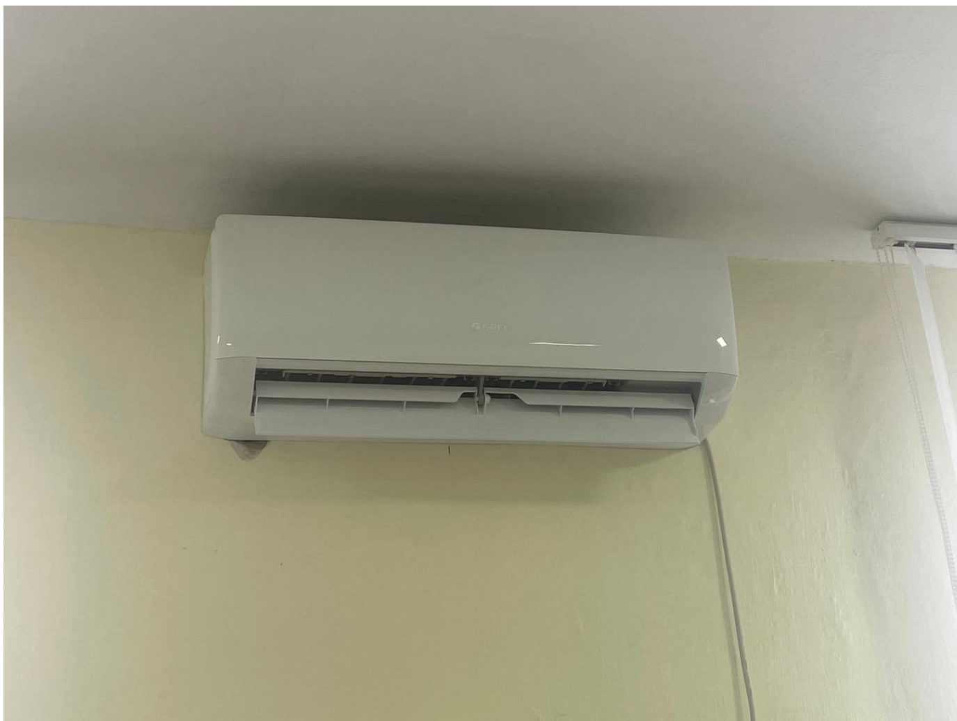
Imaginea nr. 3 Instalarea climatizorului centrul de calcul și relații cu publicul
