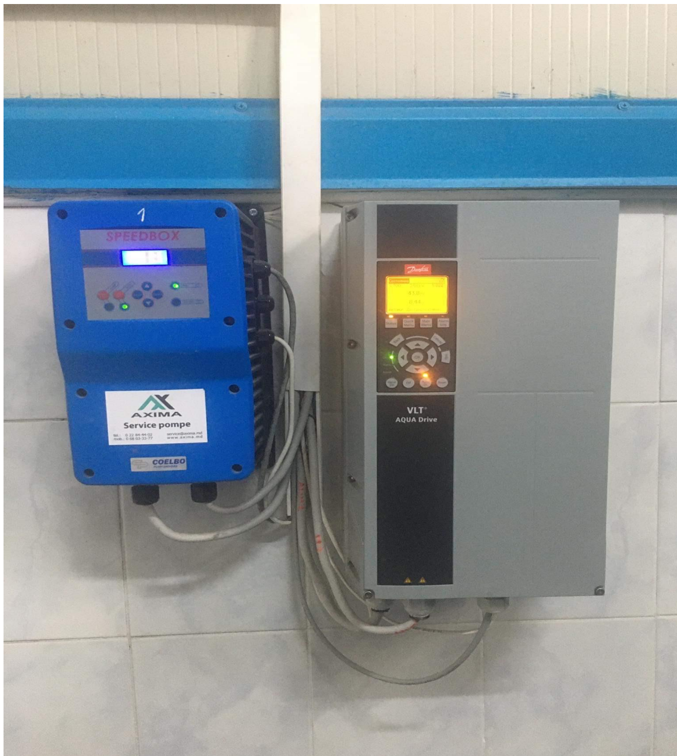
Imaginea nr.7 montarea convertizorului de frecvență SP8
