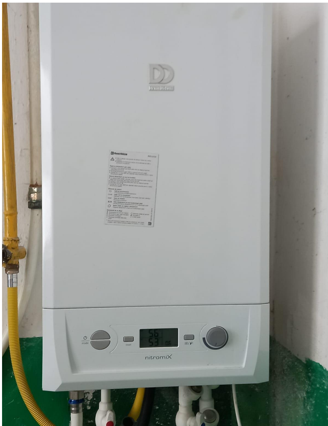
Imaginea nr. 6. Procurarea cazanului Stația de Epurare (PUR)
